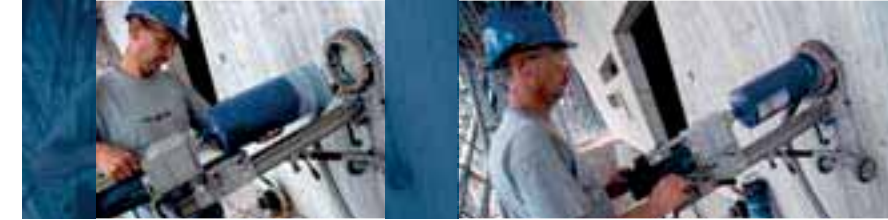
GDB 2500 WE Professional karot makinesi donatılı betonda güçlü ve sarsıntısız biçimde deler.
